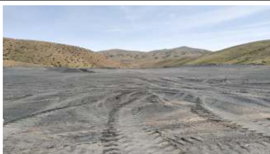
平整压实的排土场
