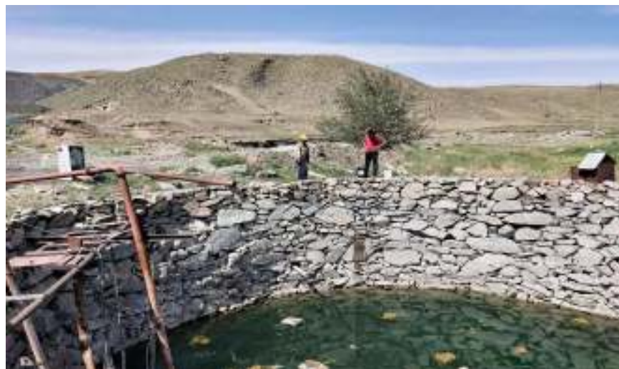
尾矿库下游监测井
