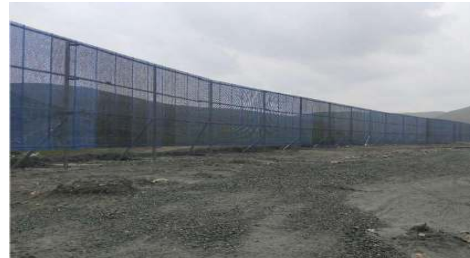
水选一车间干精矿料场设置的防风抑尘网
