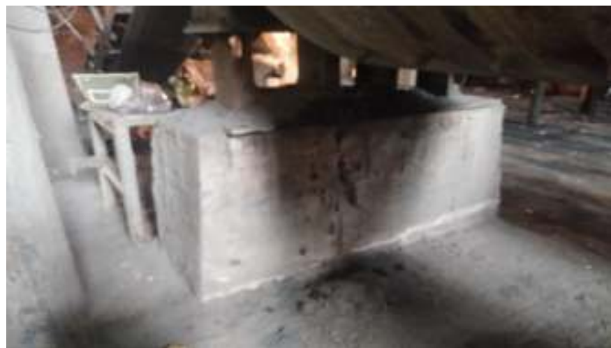
球磨机减震基础
