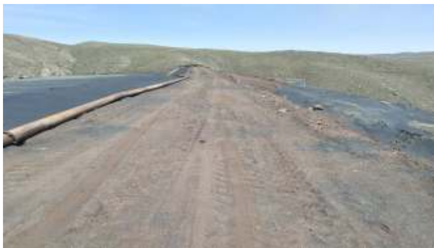
尾矿坝顶部覆土
