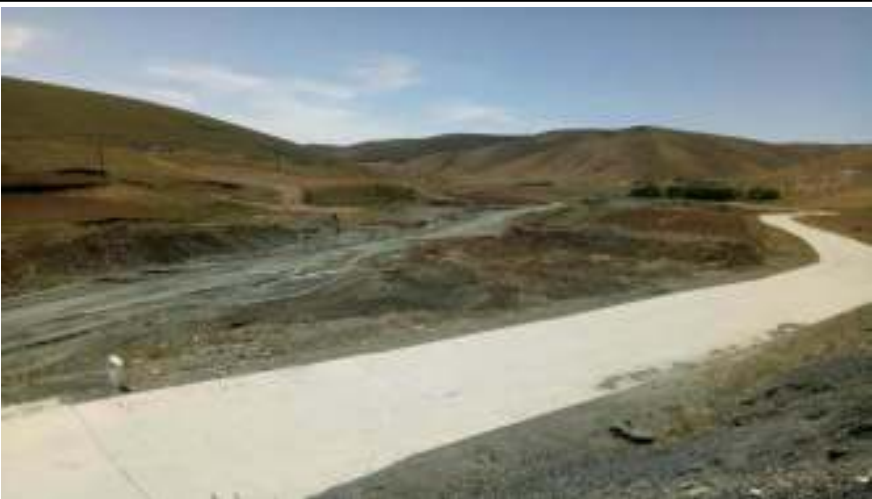
进排土场道路硬化
