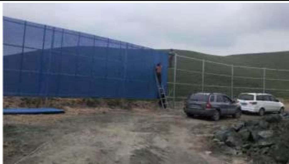
干选 1 线原矿进料场安装防风抑尘网
