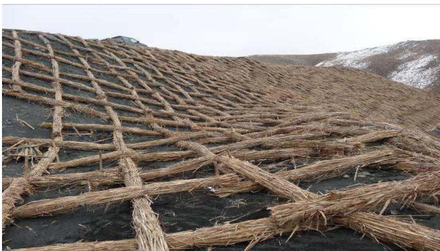
尾矿库坝体外坡采用芦苇草编扎成捆菱形状铺设
