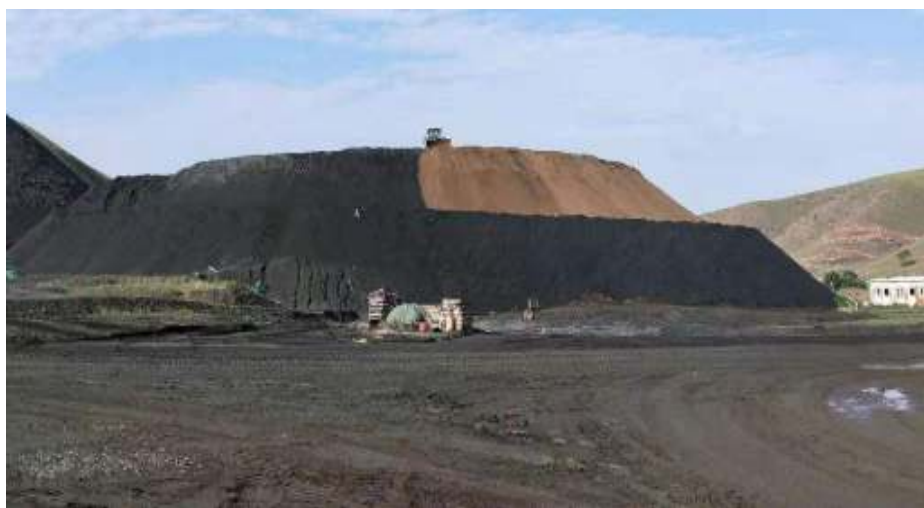
低品位干精料堆场削坡、覆土
