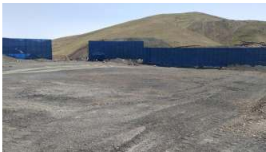
干精矿堆场东侧设有 50 米防风抑尘网
