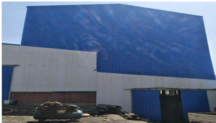
水选一车间设备全部安装在厂房内
