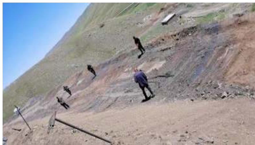
尾矿坝边坡撒播草籽
