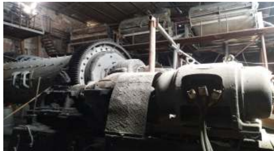
水选一车间设备减震基础
