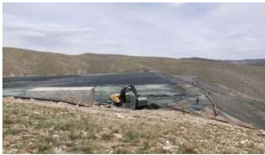
对尾矿库内尾砂进行压实
