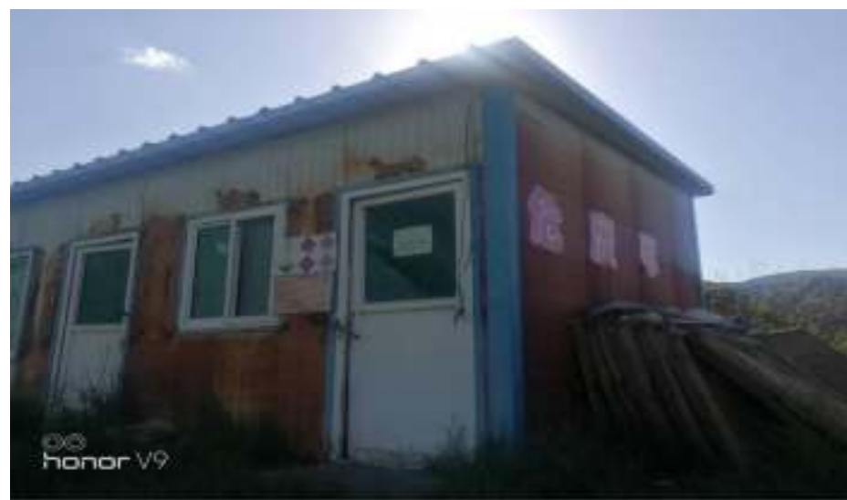
国祥矿业危险废物暂存间
