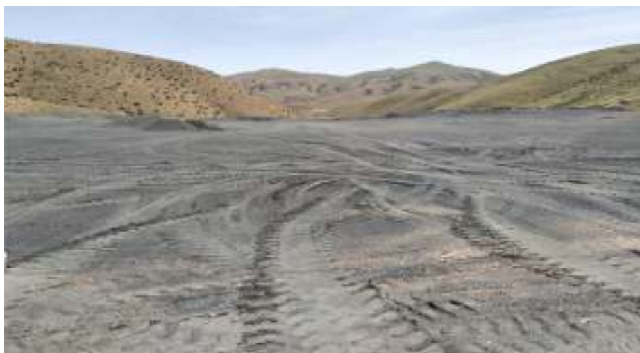
对排土场进行压实处理
