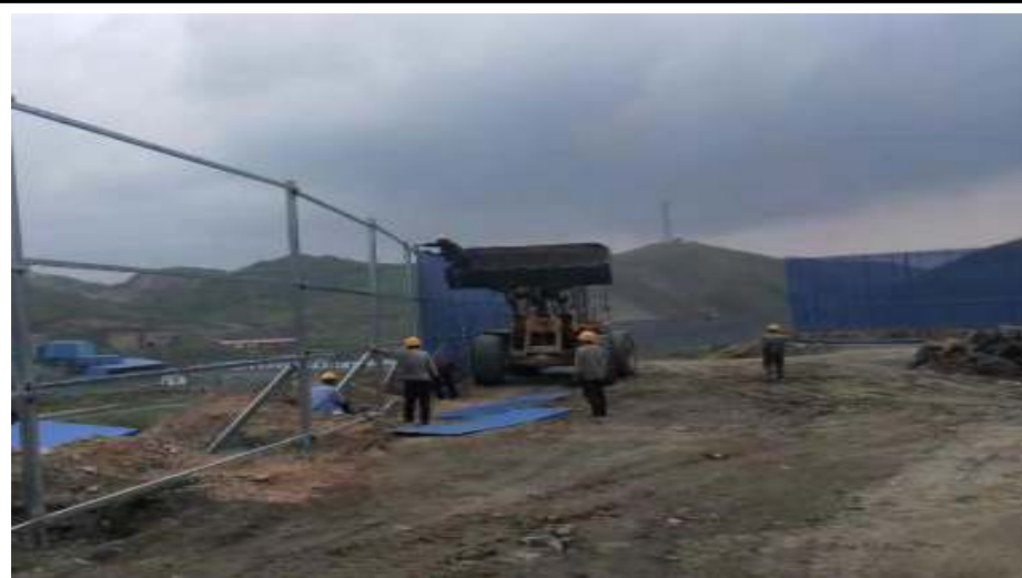
干选 2 线原矿进料场安装防风抑尘网
