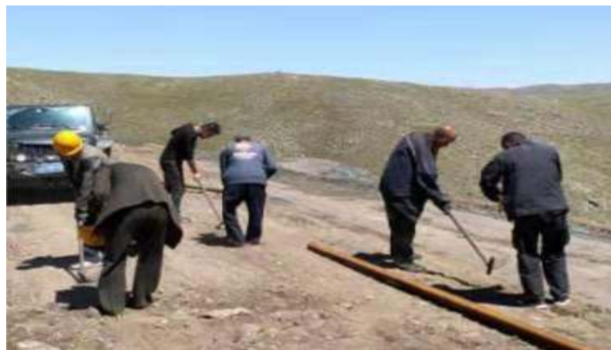
尾矿坝顶部撒播草籽
